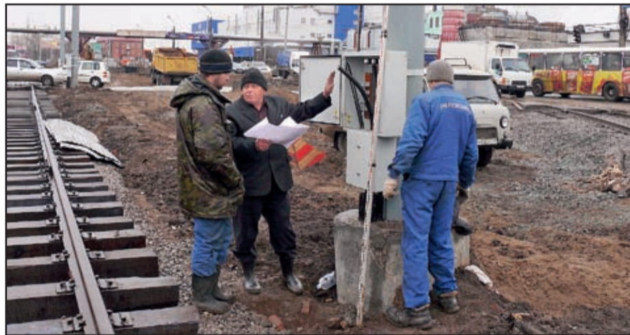
Монтаж щитов контактной сети по ул. Г.Хасана (мастер участка ЭМР Н.М.Стволлов с монтажниками В.А. Марцинковским и П.А.Бобровым).
